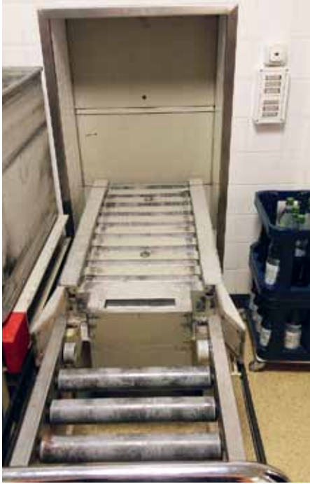
Die Behälter werden zu den Krankenhausstationen transportiert, dort be- oder entladen und per Knopfdruck zu einem neuen Ziel oder zurück zum Herkunftsort gesandt.
