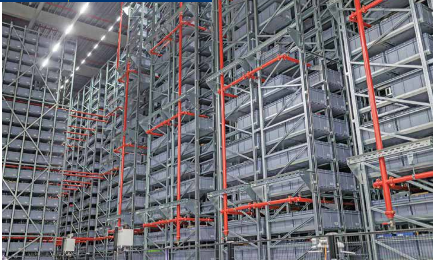
Eine höhere Lagerdichte kann den Flächenbedarf reduzieren. Zum Klimahebel wird sie, wenn dadurch weniger Gebäudefläche benötigt wird.
