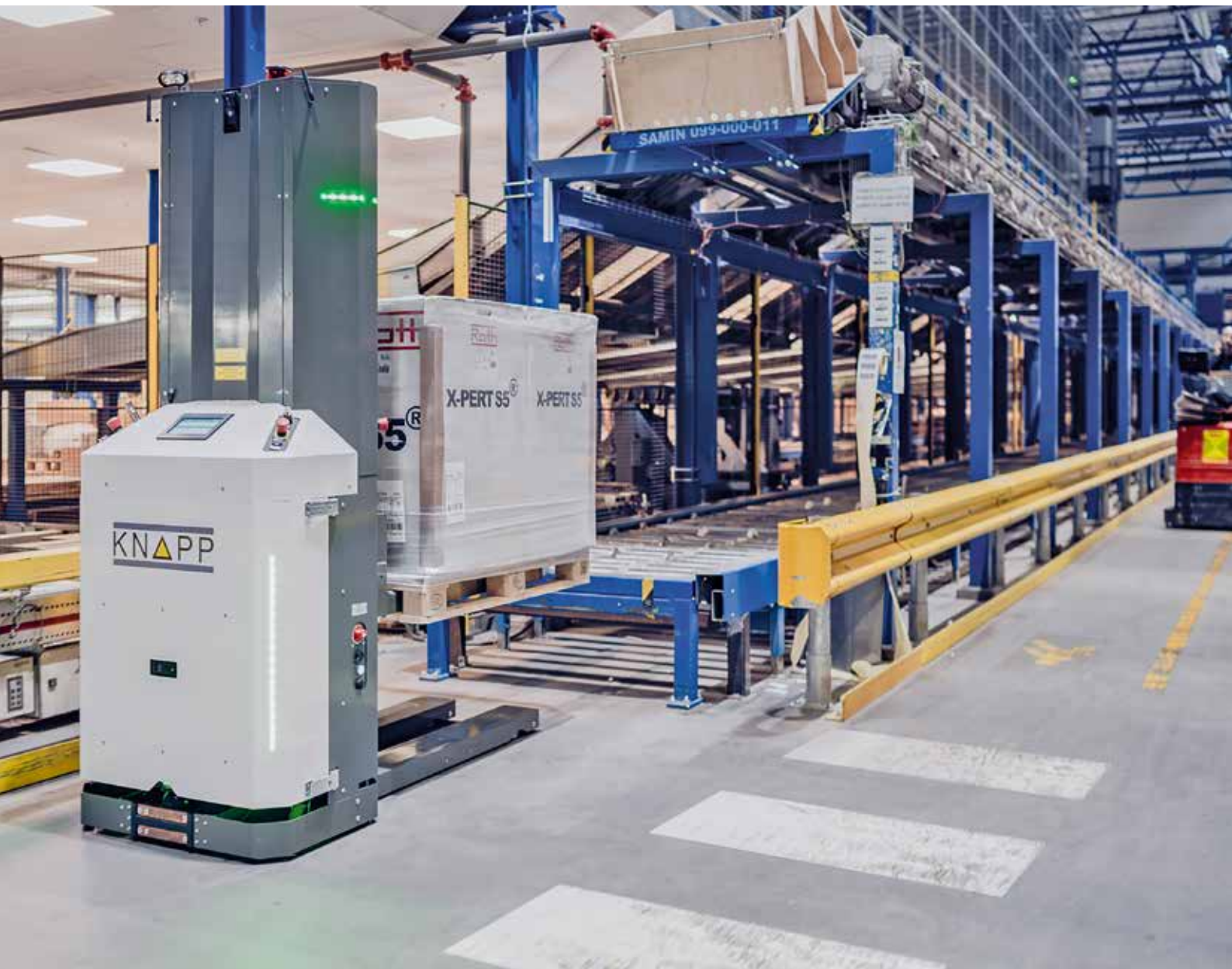
Die Palettentransporte zwischen den Lagerbereichen werden autonom von acht „Open Shuttle Fork“ übernommen.
