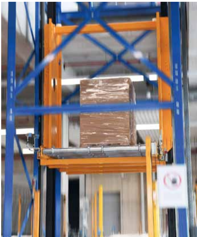
Das Fördertechniksystem verläuft in drei Ebenen, welche mit insgesamt drei Senkrechtförderern verbunden sind.
