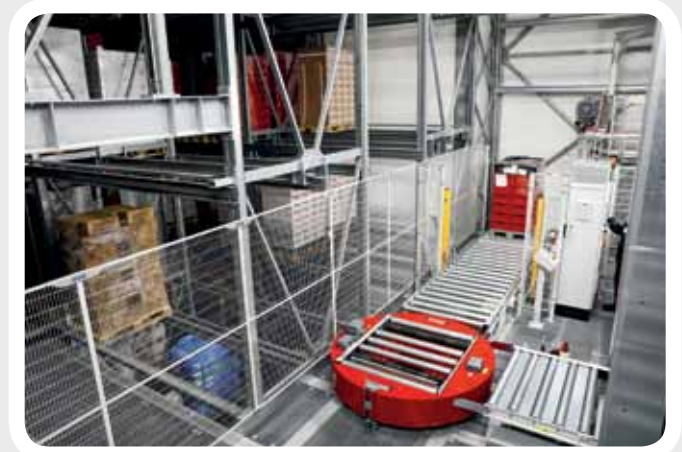
Ein- und Auslagerung in das zehngassige Tiefkühl-Hochregallager, mit fast 36.000 Hochregalstellplätzen.
