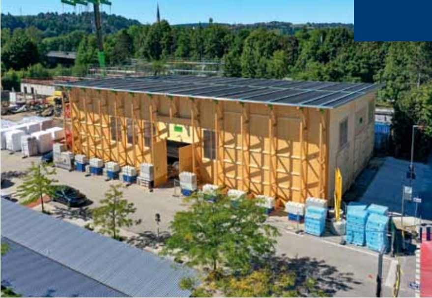
Die Feldfabrik von LiWood besteht aus Holz und trägt zu der effizienten Bauweise bei.
