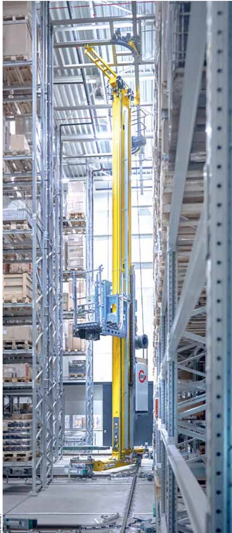
Das kurvengängige RBG lagert Paletten optimal über mehrere Gassen im Hochregallager ein- und aus.
