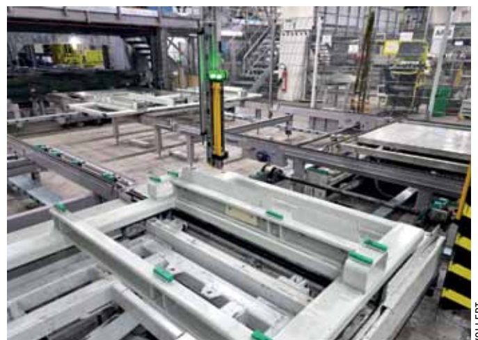
Querkettenförderer erweitert: Gemeinsam mit Vollert wurde der bestehende Querkettenförderer deshalb um vier zusätzliche Pufferplätze erweitert. Das schafft Kapazitäten für künftige Leistungssteigerungen, denn so können mehrere Skids vor und nach dem Arbeitsplatz gepuffert werden.
