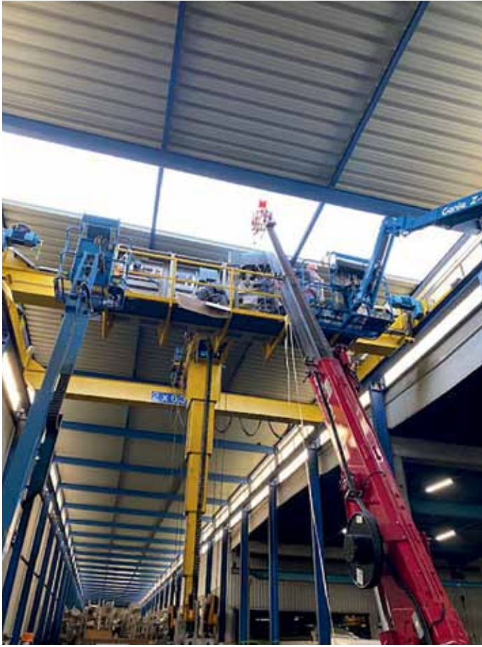
Um dem Platzmangel beim Retrofit unter dem Dach zu begegnen, setzte Kasto drei Gelenkheber sowie einen Autokran ein und öffnete zeitweise die Decke in Halle 9.
