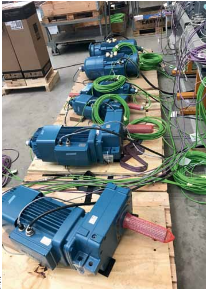
Kasto brachte die komplette Antriebstechnik am Lagerkran auf den neuesten Stand.
