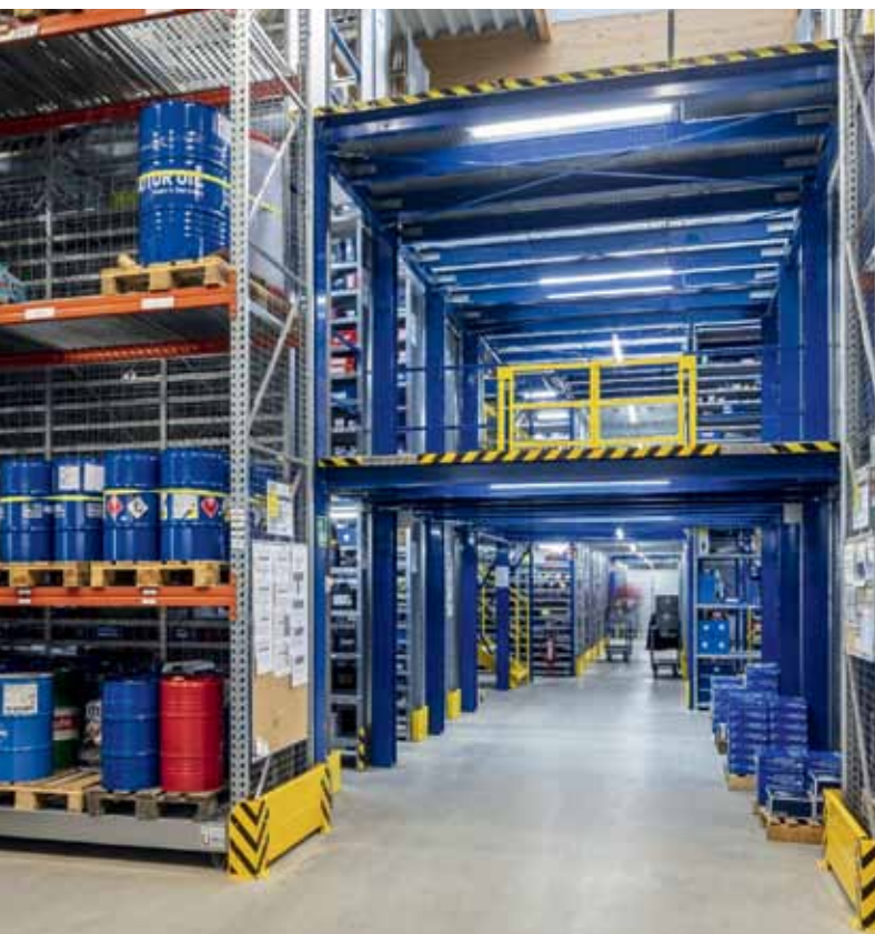
Das neue Herz der Logistikprozesse: Die dreigeschossige Fachbodenregalanlage mit den anschließenden Palettenregalen inkl. Ölwannen.
