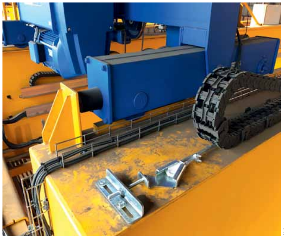
Seil statt Rinne: Das Führungsseil ist auf der Kranbrücke befestigt
