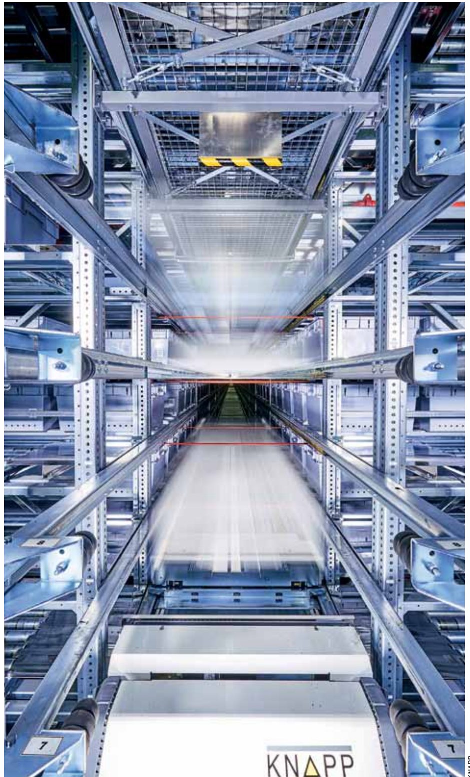
Das OSR Shuttle umfasst insgesamt 21 Regalgassen mit 26 Ebenen – 546 Shuttles versorgen 556.000 Lagerplätze. Zwei Quergurtsorter verbinden den Lagerbereich mit dem Kommissionierbereich.
