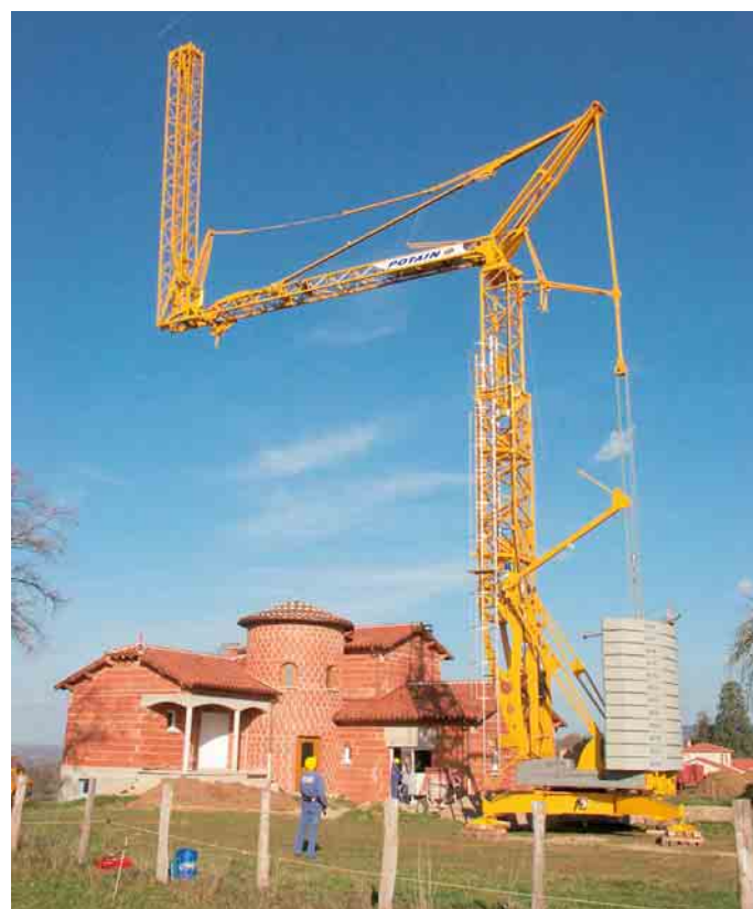
Igo T 70 mit teleskopierbarem Turm
