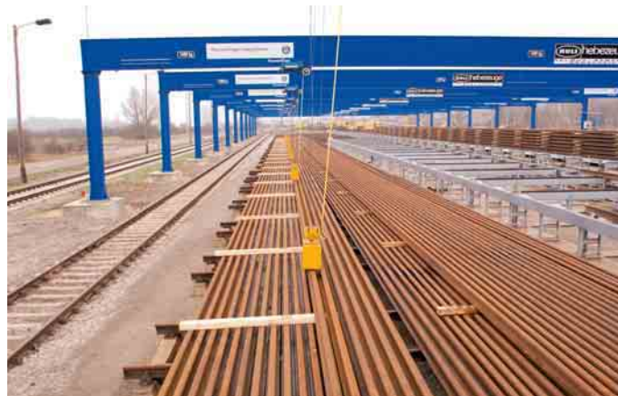
Referenzprojekt: Bockkrananlage zum Transport von bis zu 180 m langen Schienen (Bilder: Kuli Kempkes)
