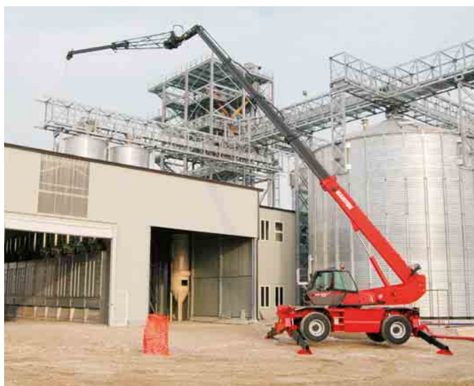
Teleskopmaschine MRT 3050 als Kran
