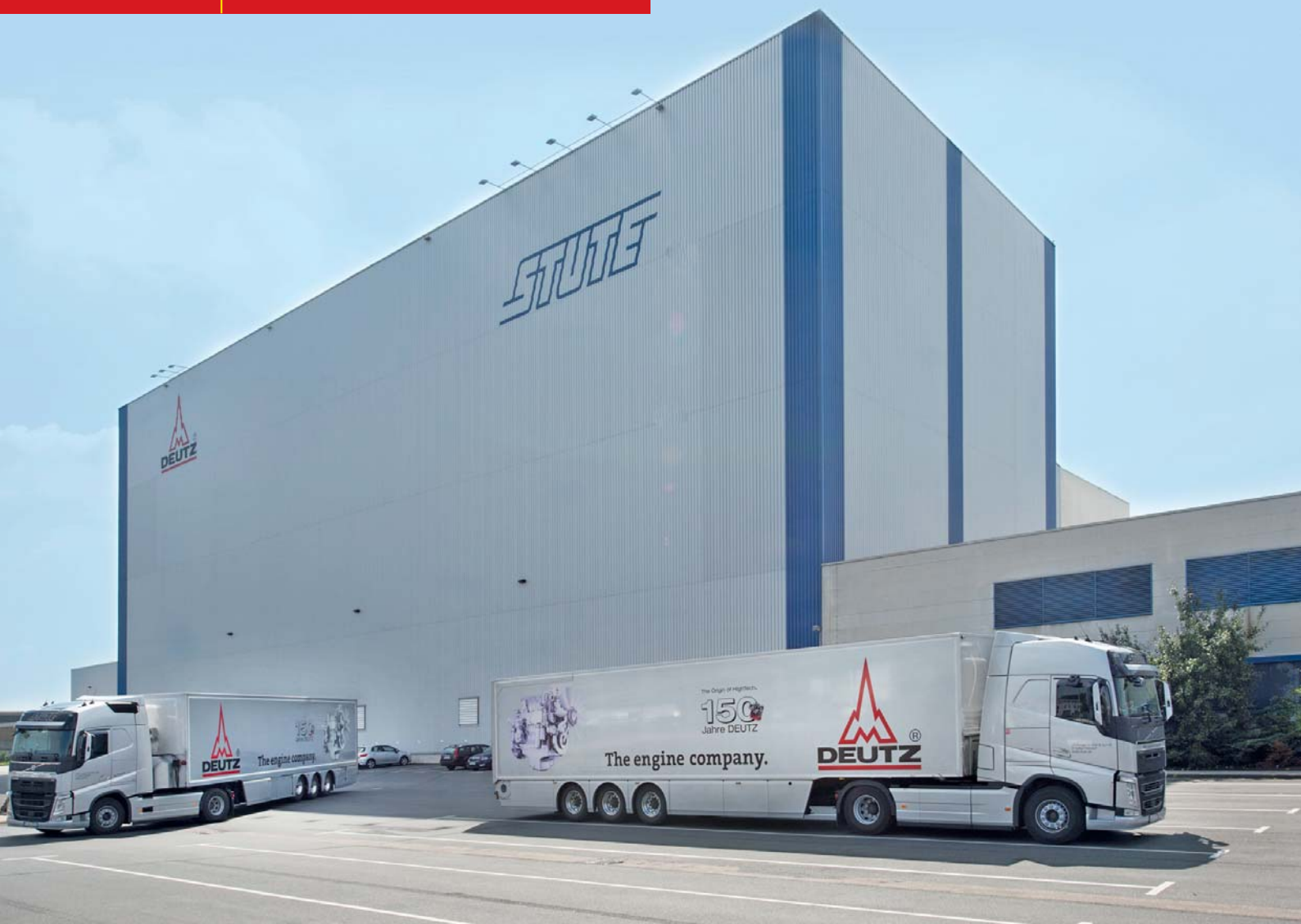
❶ In einem Retrofit-Projekt wurde ein Großteil der Regalbediengeräte im Logistikzentrum des Deutz-Motorenwerks in Köln auf den aktuellen Stand der Technik gebracht.
